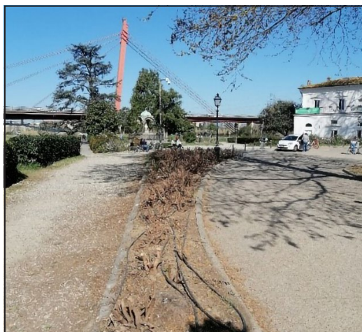
Figura 6.11 - Posizionamento irregolare delle linee gocciolanti in una porzione di aiuola in un parco urbano.
