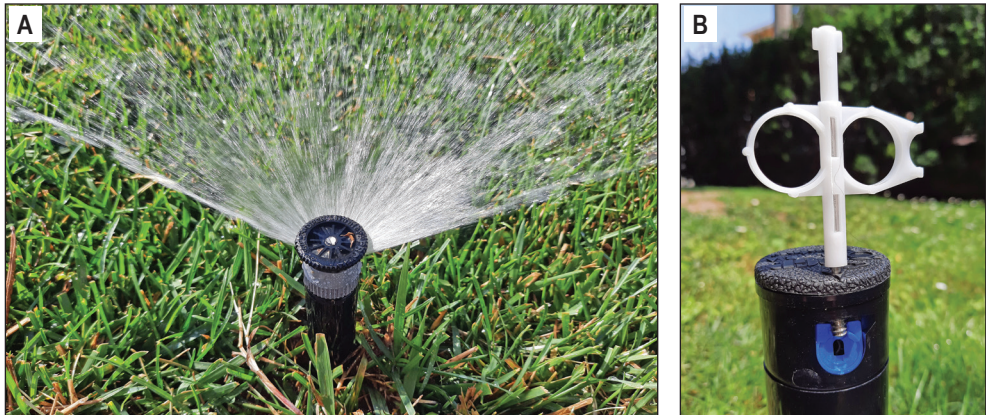
Figura 6.3 – A sinistra, vite rompigitto di un irrigatore statico visibile al centro della testina (a). A destra, negli irrigatori a turbina la vite che tiene in sede il bocchaglio può avere anche funzione di vite rompigitto (b).
