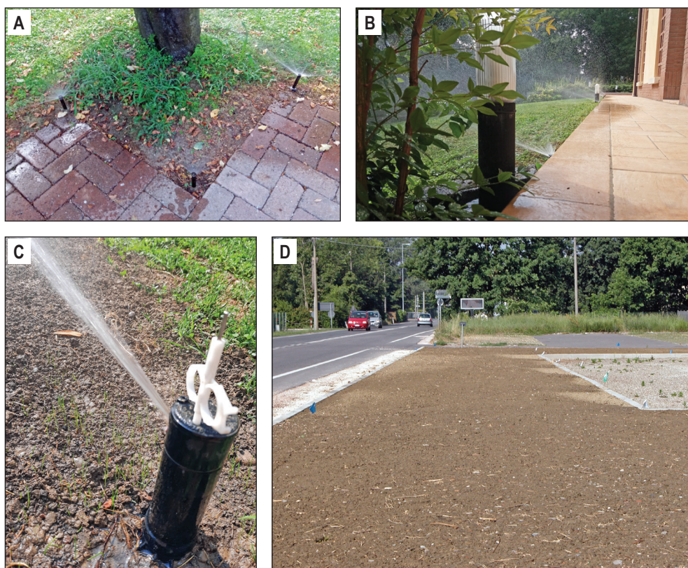
Figura 6.7 – Testine con differente regolazione per soddisfare le varie esigenze in funzione della conformazione delle aree da servire (a). La bagnatura delle pavimentazioni è uno dei principali problemi in materia di regolazione dell'area di lavoro degli irrigatori che oltretutto sono sempre soggetti ad una minima influenza del vento (b). In (c) chiave di regolazione dell'angolo di lavoro inserita su di un irrigatore in funzione. La regolazione è fondamentale al fine di non lasciare aree non correttamente irrigate (d).
