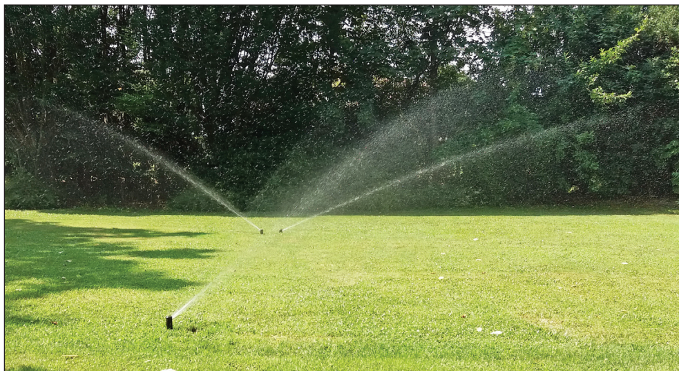
Figura 6.1 – Irrigazione a pioggia al servizio del tappeto erboso di un parco realizzata con irrigatori a scomparsa.
