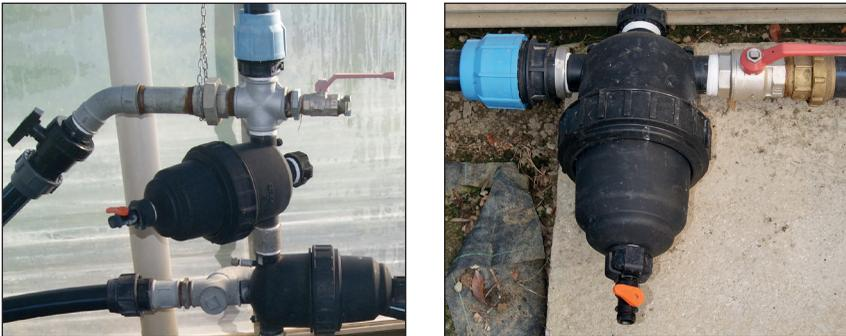
**Figura 2.3** | Filtrazione primaria e filtrazione finale.
